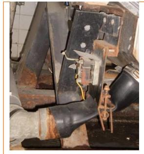
*Fig. 1.8 Válvula y tubería de drenaje*
