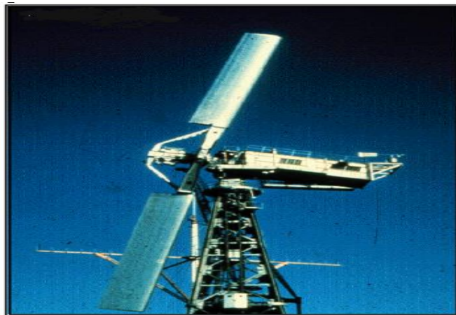
Fig. 1.2 Aerogenerador de eje Horizontal de 1.25 MW de Smith-Putnam Fuente: www.windpower.com
