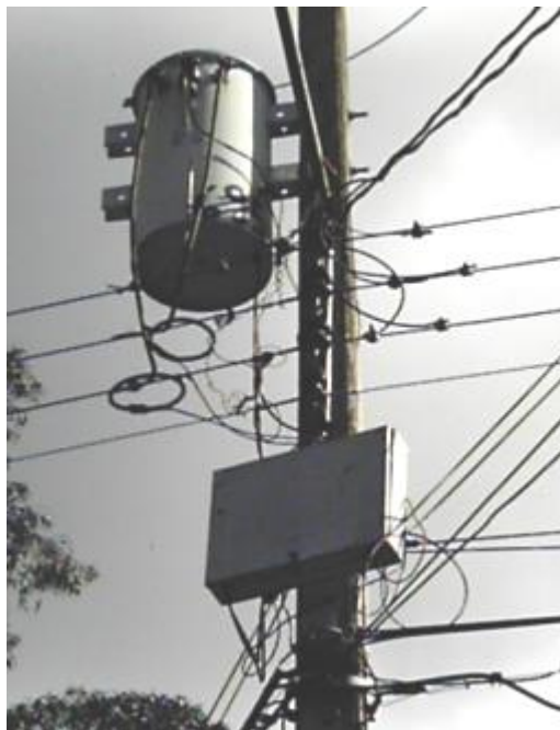
Fotografía 6. Conexión del equipo en las bajantes del transformador.
