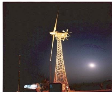
Fig.1.11. Orientación del equipo mediante molinos auxiliares.
