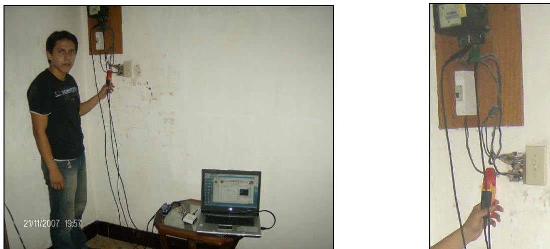
Figura 3.12. Medición en un sistema monofásico
