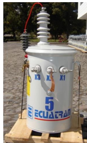
Fig. 1: Transformador Monofásico Autoprotegido
