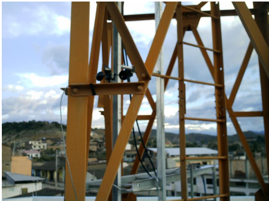
Figura 61: Montaje del anemómetro en la torre, Zapotillo
