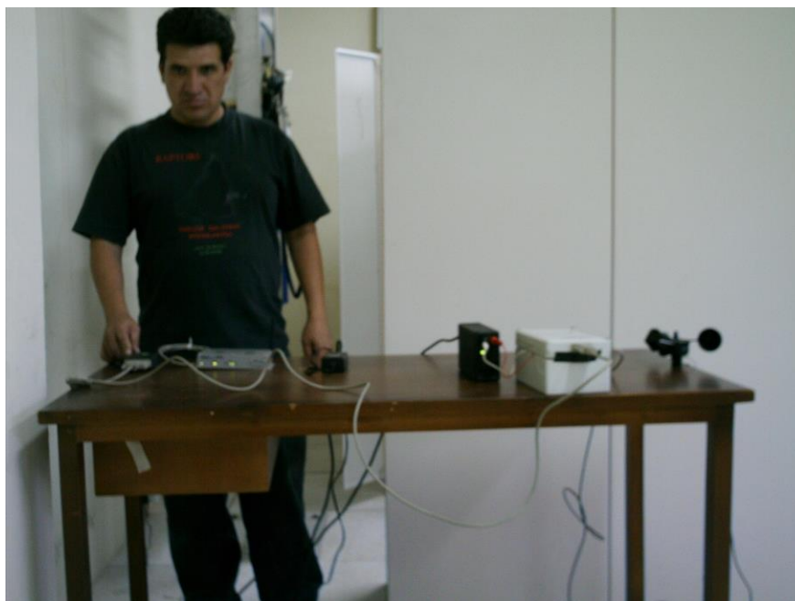
Figura 60: Montaje del sistema en la sala de equipos Pacifictel Zapotillo
