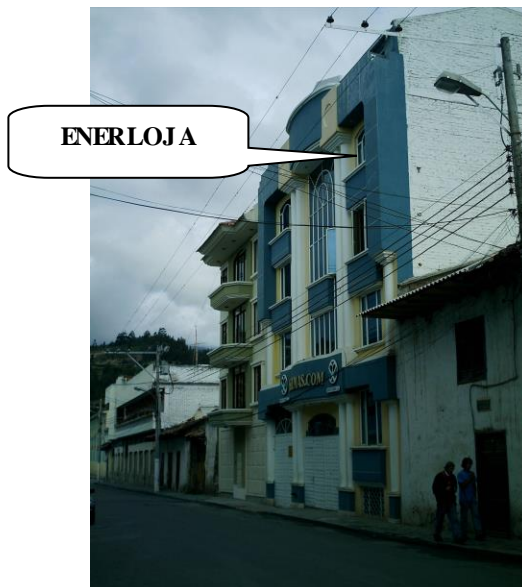
Figura 37: Edificio SISTEMAS.COM ENERLOJA
