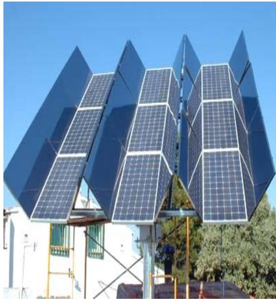
**Figura 2.14- Seguidor y concentrador combinados**
