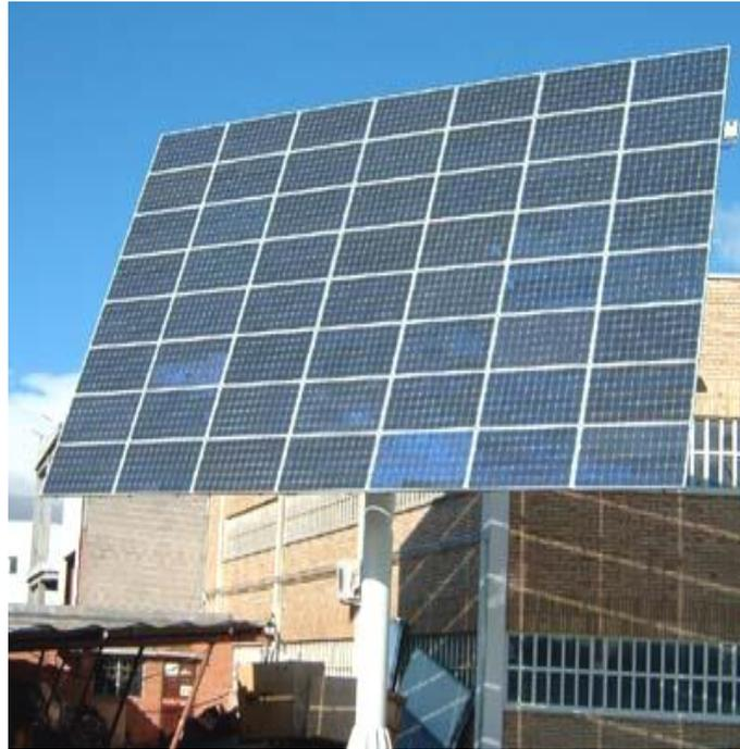
**Figura 2.17- Seguidor monoposte de dos ejes para instalaciones de 5 kW**
