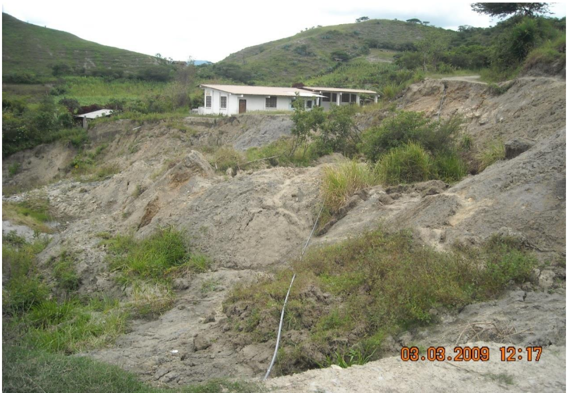
VÍA INTERRUPTIDA POR EFECTOS DEL DESLIZAMIENTO.
