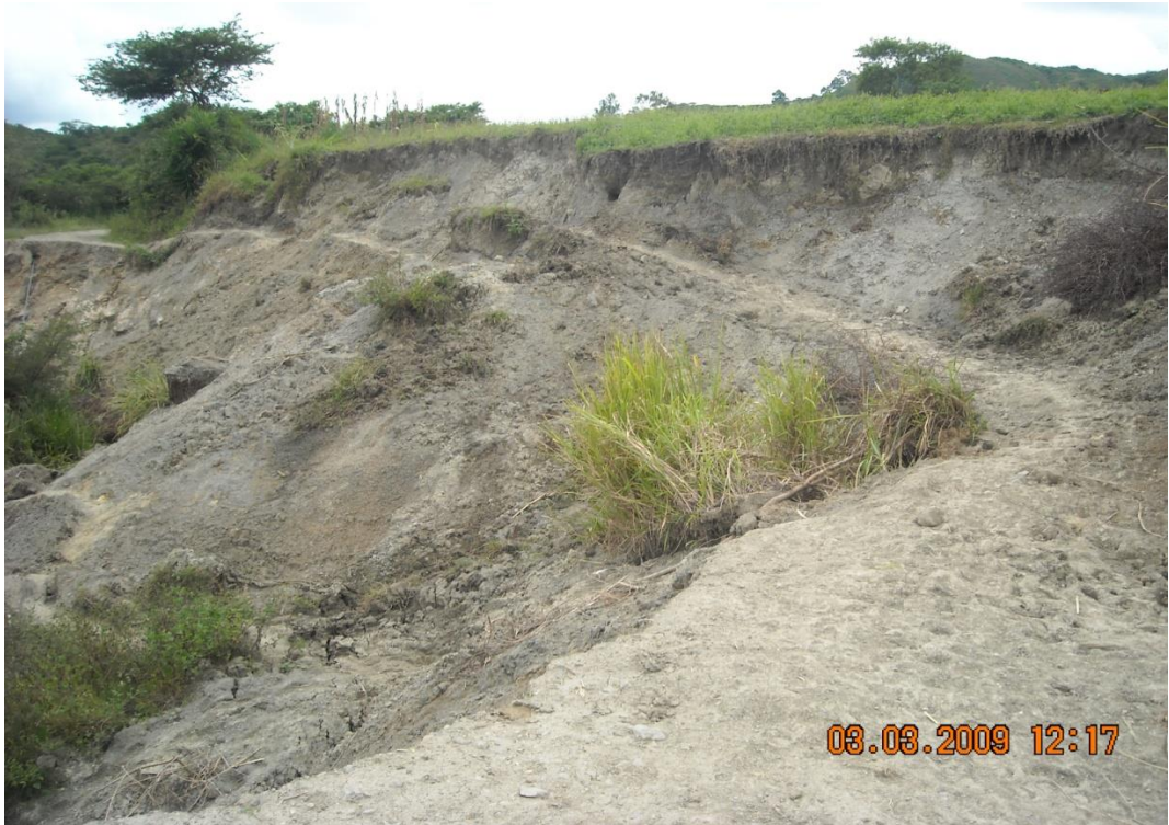
VÍA PRINCIPAL DEL BARRIO SAN FRANCISCO, UBICADA EN LA CORONA DEL DESLIZAMIENTO
