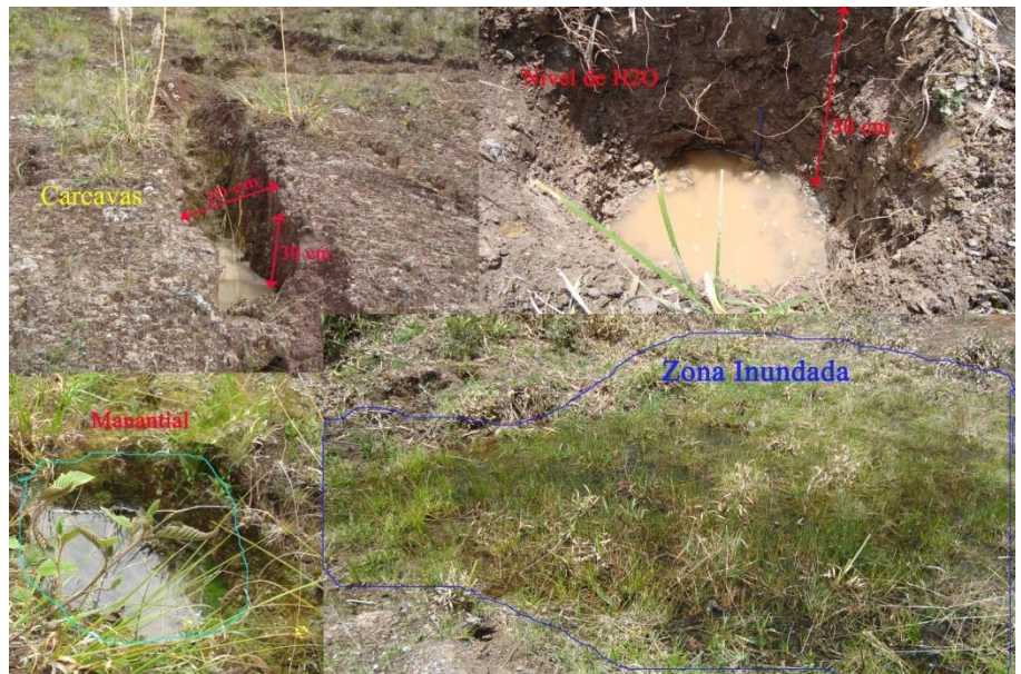
Fotografía 28. Nivel de agua en el Deslizamiento 1
