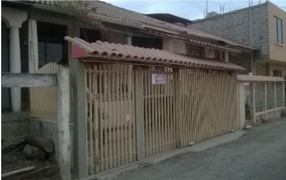
FACHADA PRINCIPAL DE LA EMPRESA (RIDRENSUR EP)
