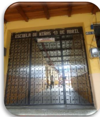
Figura 15f. Instalaciones de la escuela 13 de Abril Fuente: Escuela 13 de Abril
