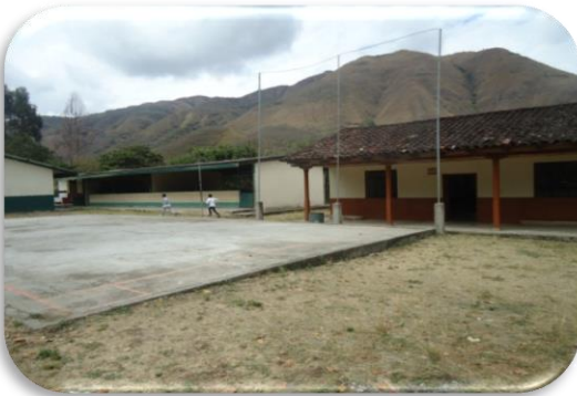
Figura 15c. Instalaciones de la escuela Francisco Javier Salazar Fuente: Escuela Francisco Javier Salazar
