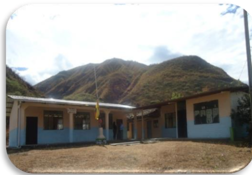
Figura 15d. Instalaciones de la escuela Piedad Burneo de Ojeda Fuente: Escuela Piedad Burneo de Ojeda
