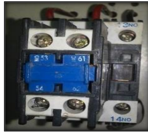
FIG 47. Contactor Fuente: El Autor
