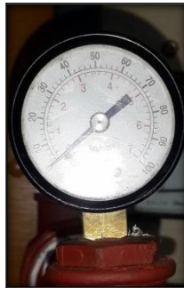
FIG 51. Manómetro para medir presiones a la entrada de la bomba Fuente: El Autor
