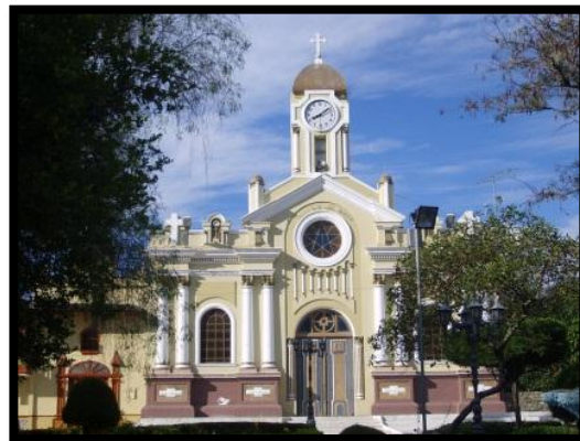
Foto N° 2 Iglesia de la parroquia Vilcabamba.
