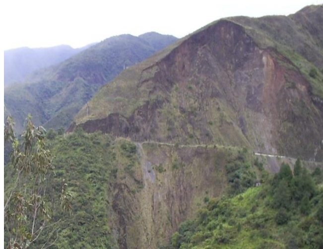
Figura 25. Foto Deslizamiento Nor-oeste del Área de Estudio
