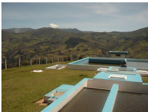
Fotografía 47. Planta de tratamiento del agua.
