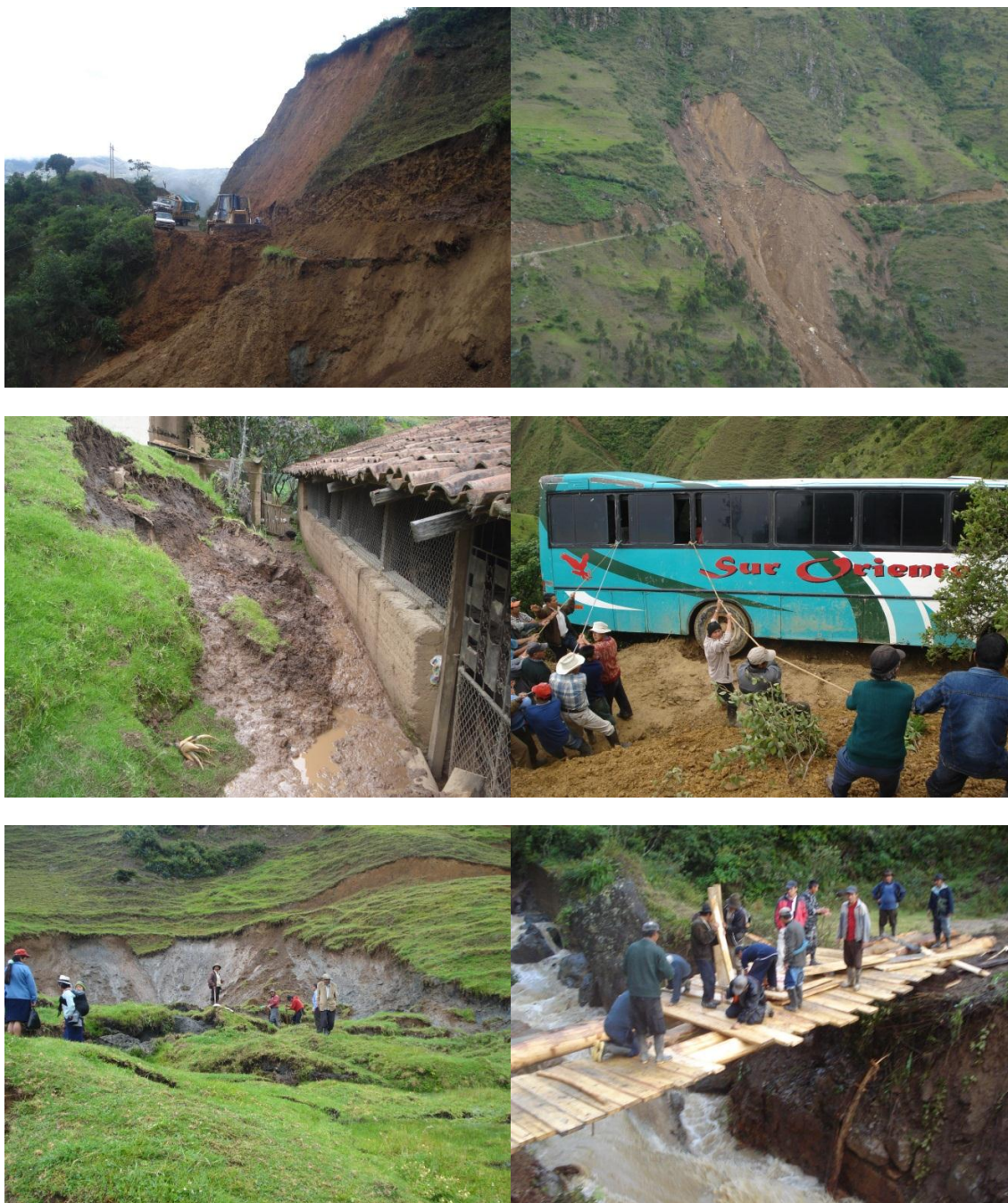
Fotografía 62. Consecuencias de las severas lluvias en el año 2008, causando pérdidas económicas, muchos sembríos y la quedándose incomunicados con las parroquias vecinas.
