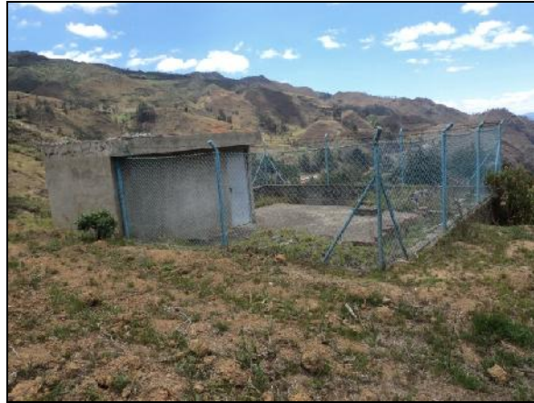
Foto 61. Tanque de agua entubada Sitio: Parroquia Chantaco Fecha: Noviembre de 2011 Coordenadas: 685269; 9571472; 2185
