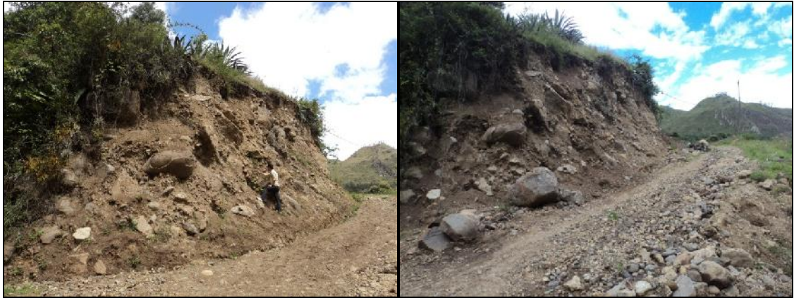
Foto 23. Deposito aluvial Sitio: Parroquia Chantaco Fecha: Noviembre de 2011 Coordenadas: 685088; 9568455; 2014
