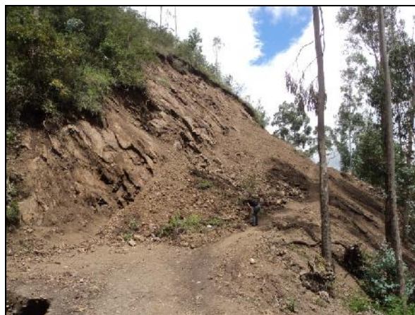
Foto 47. Deslizamiento 2 Sitio: Parroquia Chantaco Fecha: Noviembre de 2011 Coordenadas: 685489; 9570639; 2241
