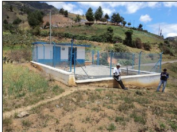
Foto 60. Tanque de agua potable Sitio: Parroquia Chantaco Fecha: Noviembre de 2011 Coordenadas: 685267; 9571468; 2185
