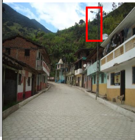
Fotografía 19: Alumbrado público del centro
