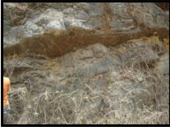
Fotografía N° 26. Macizo Rocoso N° 13
