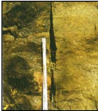
Fotografía 5. Discontinuidad de abertura muy ancha sin relleno, en areniscas.
