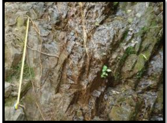
Fotografía N° 15. Macizo Rocoso N° 2
