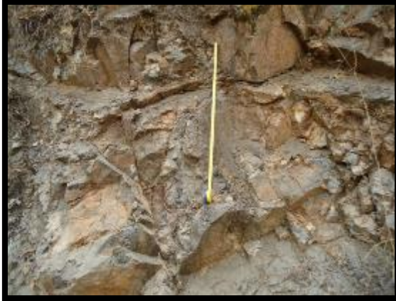
Fotografía N° 14. Macizo Rocoso N° 1
