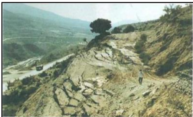
Fotografía 1.- Daños a autovías por deslizamientos (Granada)
