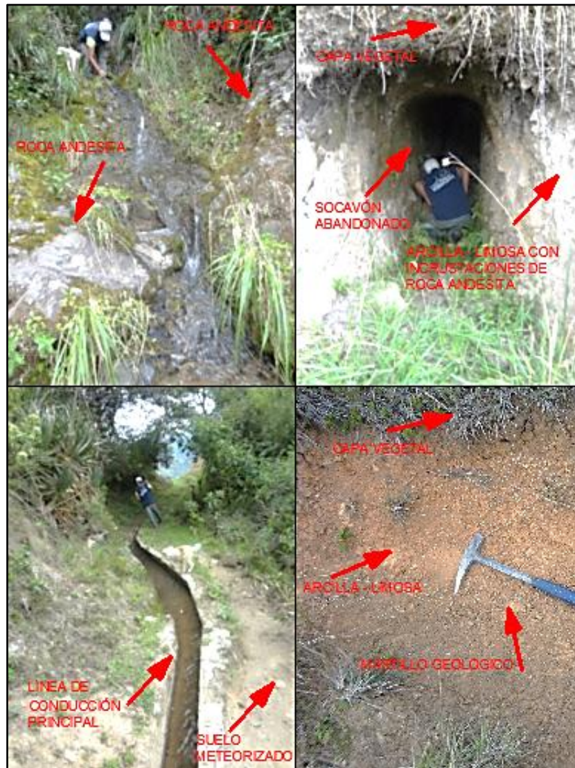
Fotografía 11. Afloramientos de la línea de conducción principal.
