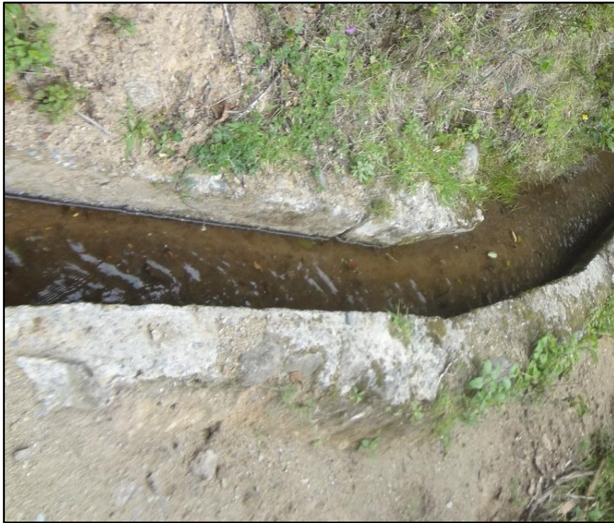
Fotografía 10. Línea de conducción principal.
