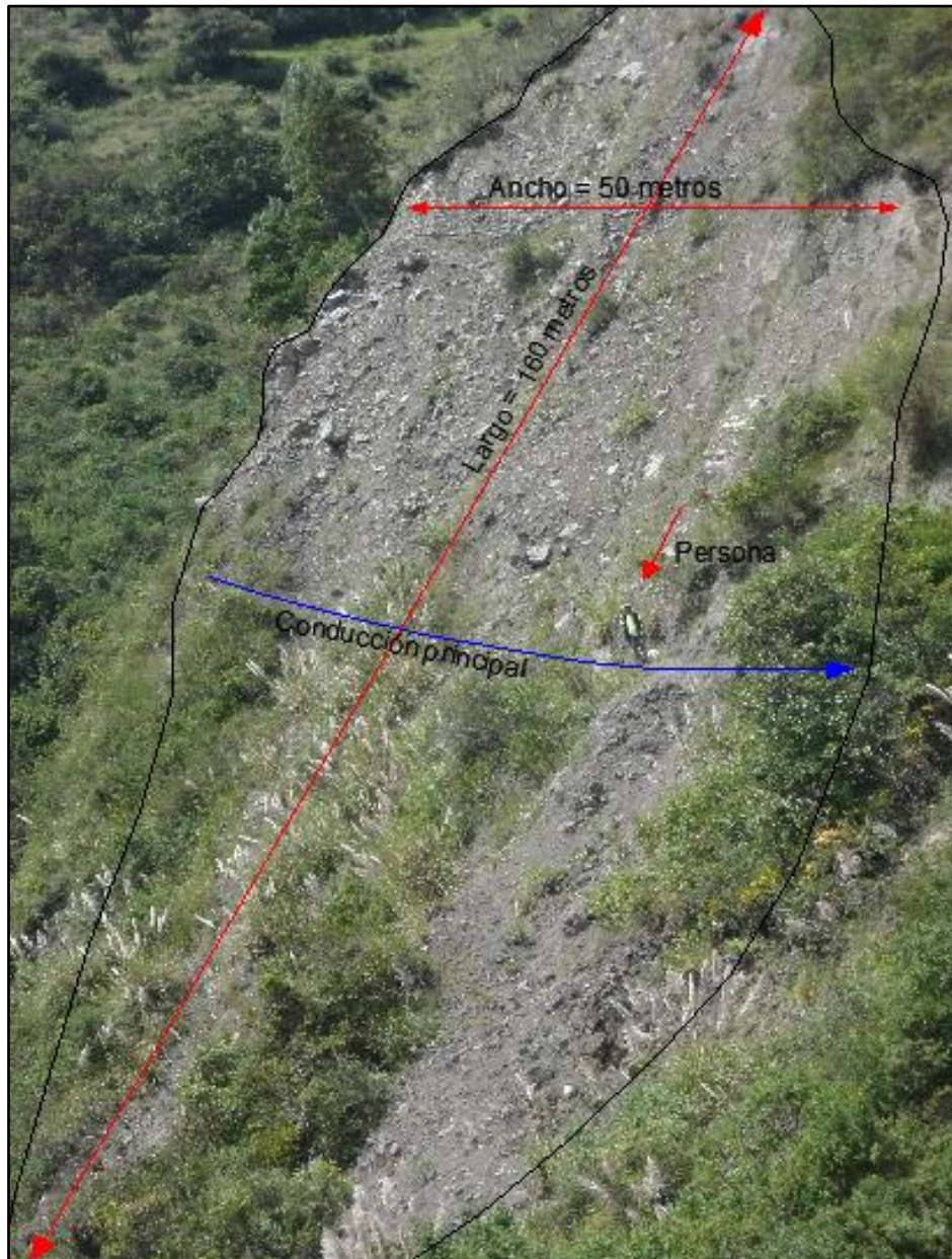
Fotografía 7. Deslizamiento traslacional de rocas y suelos.
