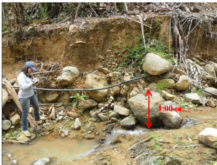
Fotografía 19. Material aluvial con rodados que superan el metro de diámetro.
