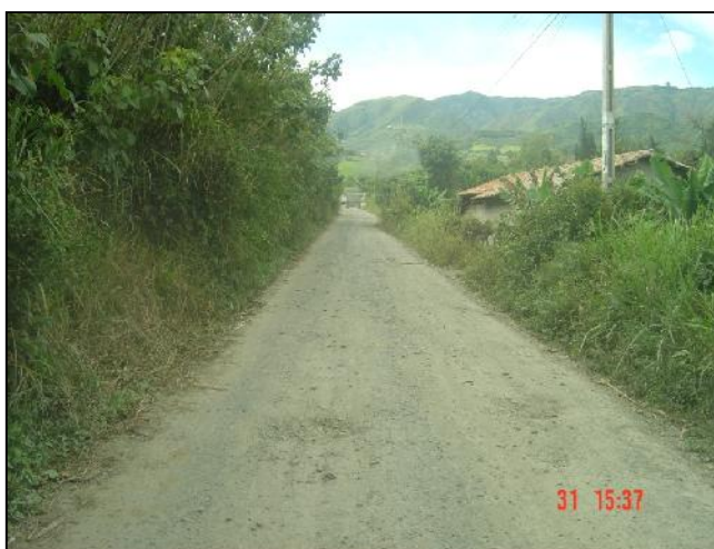
Fotografía N°25: Vía lastrada que conduce al barrio “San Francisco Bajo”
