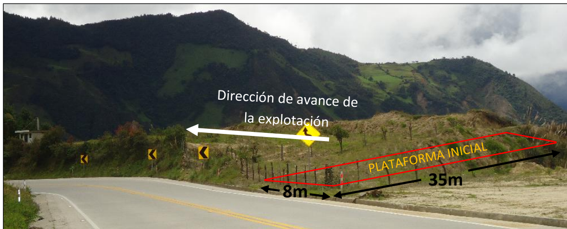
Figura 5: Ubicación y dimensiones de la plataforma inicial en el área minera IML-SANTIAGO.
