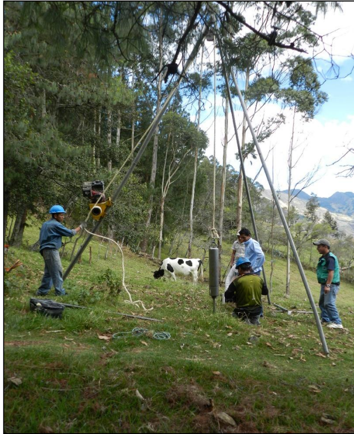
Figura N° 6. Ensayo de penetración estándar. S.P.T (Y: 9607596; X: 684014). Fuente: El Autor
