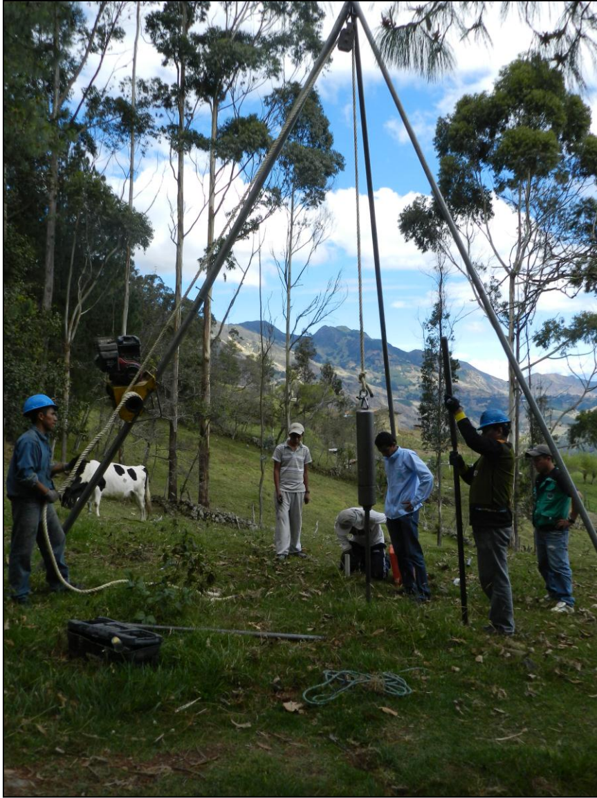
Fotografía 8. Realización del S.P.T.
