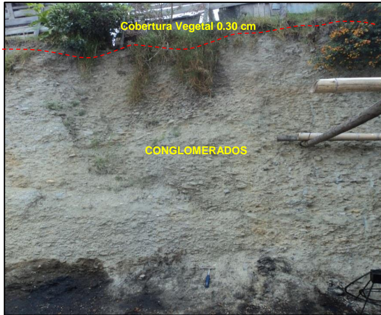
Figura 43. Afloramiento de conglomerado (Ciudadela “Los Operadores”).
