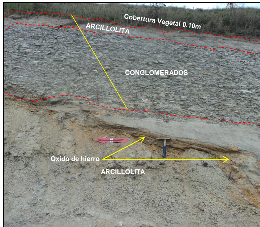
Figura 49. Afloramiento de arcillolita y conglomerados en la Vía de Integración Barrial.
