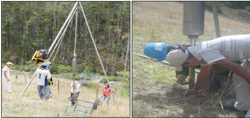
Figura 18. Fotografía de Ensayo de Penetración estándar
