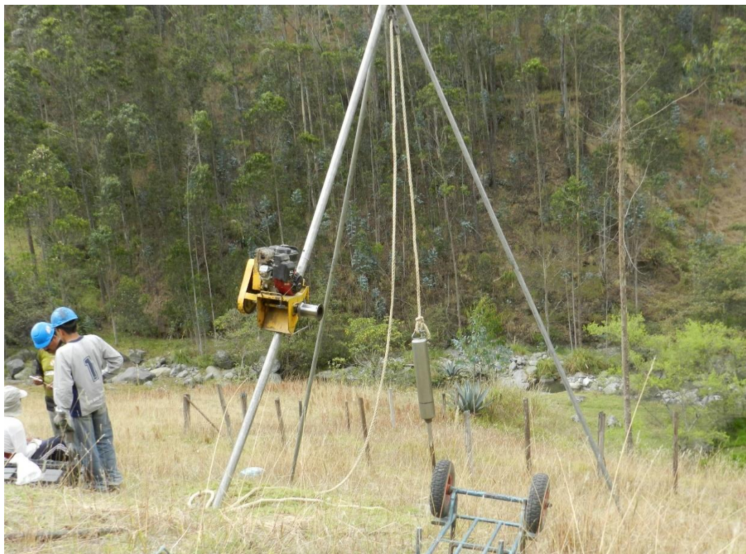
Fotografía 5. Ensayo de Penetración Estándar
