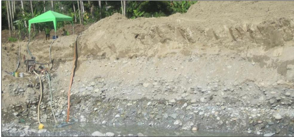
**Figura 59.** Punto bajo y bombas de agua para control del nivel freático
