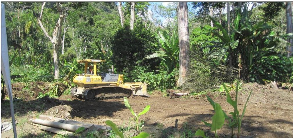
**Figura 50.** Desbroce con tractor Komatsu D61EX
