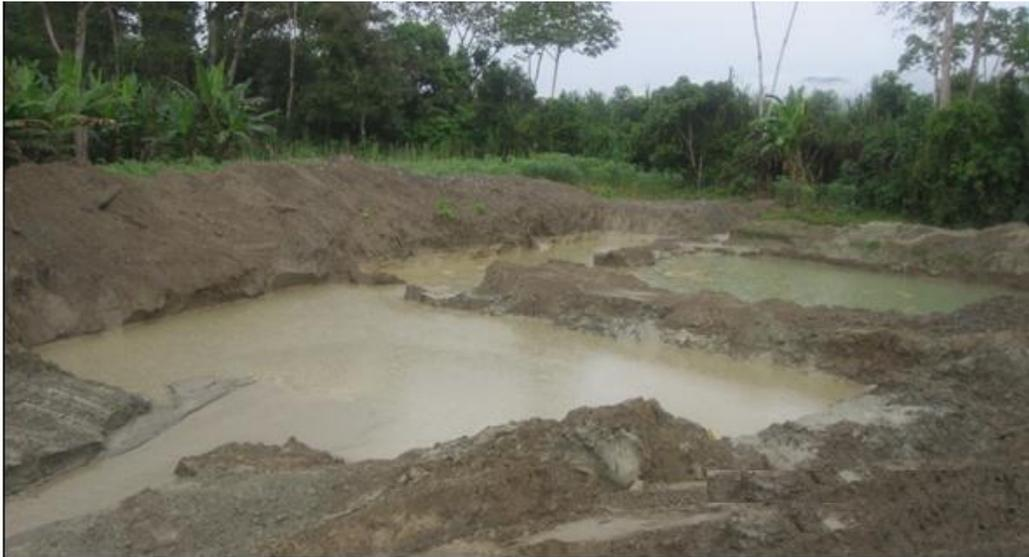
**Figura 61.** Piscinas para recirculación de aguas
