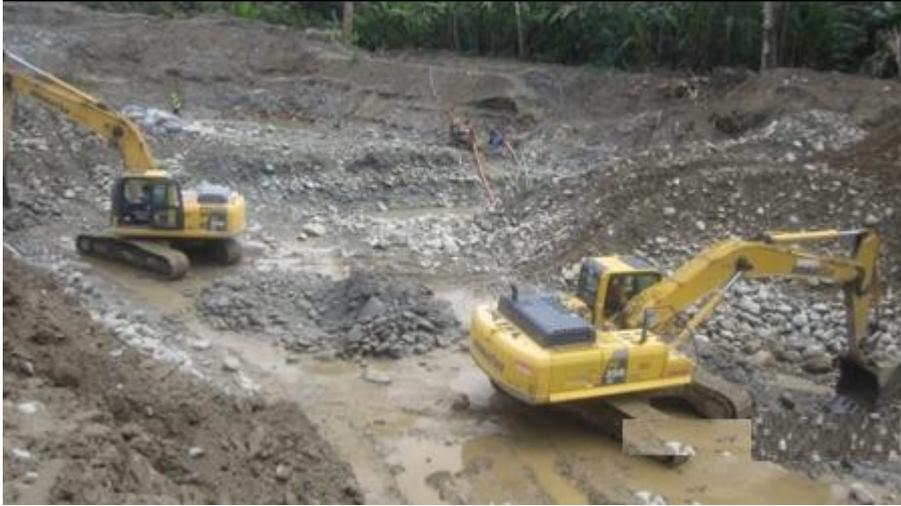
**Figura 53.** Re banqueo de gravas y control de agua por bombeo
