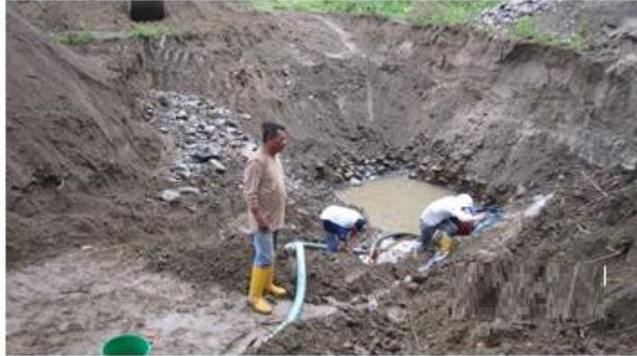
**Figura 21:** Control del nivel freático.
