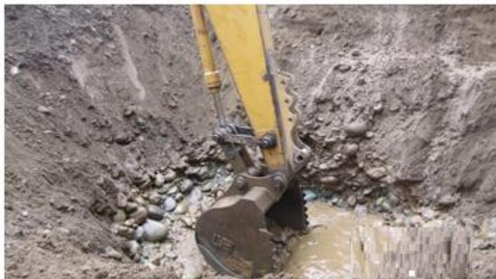
**Figura 20:** Excavación de trinchera
