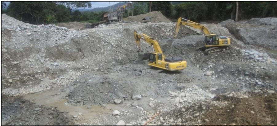
**Figura 54.** Transporte de gravas con uso de excavadoras (re banqueo)
