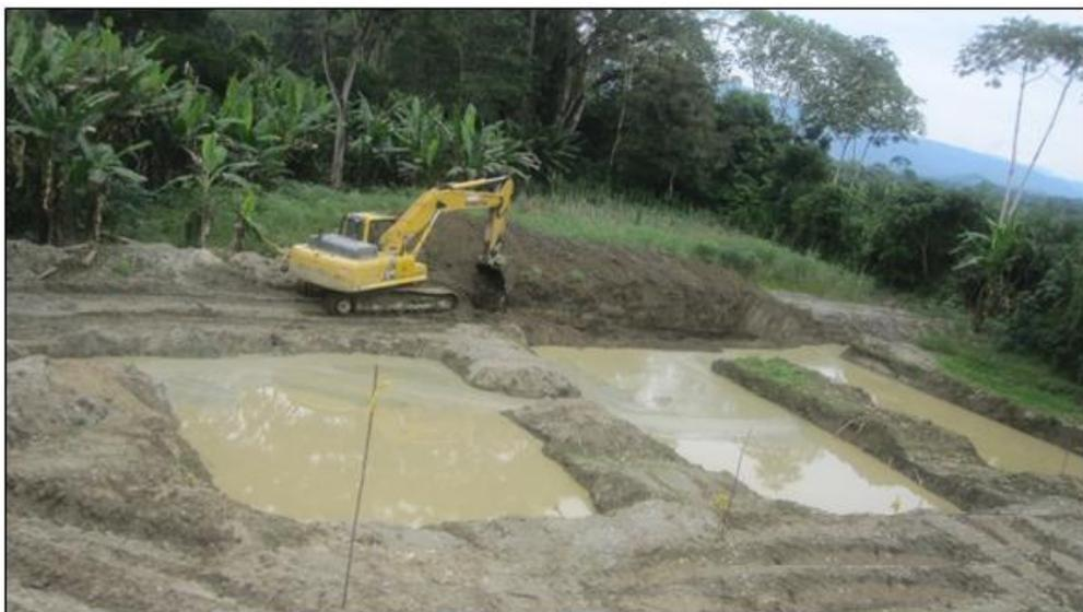
**Figura 60.** Piscinas de sedimentación y decantación
