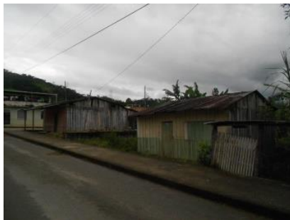
Figura 23. Viviendas de construcción de madera Fuente: El Autor
