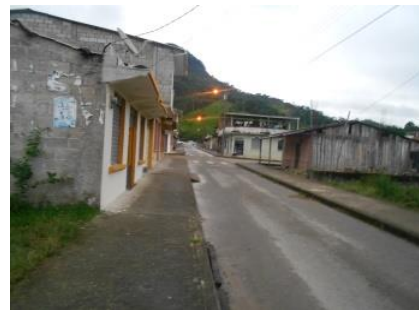
Figura 24. Viviendas de construcción mixta Fuente: El Autor
