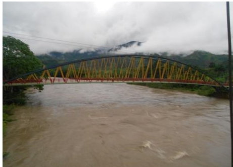
Figura 27. Puente de comunicación con San Carlos de las Minas (Capacidad 60 ton)
