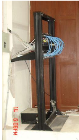
Imagen 4.2. Instalación del Rack
