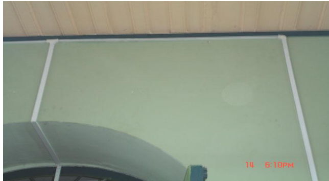
Imagen 4.1. Colocación de canaletas
