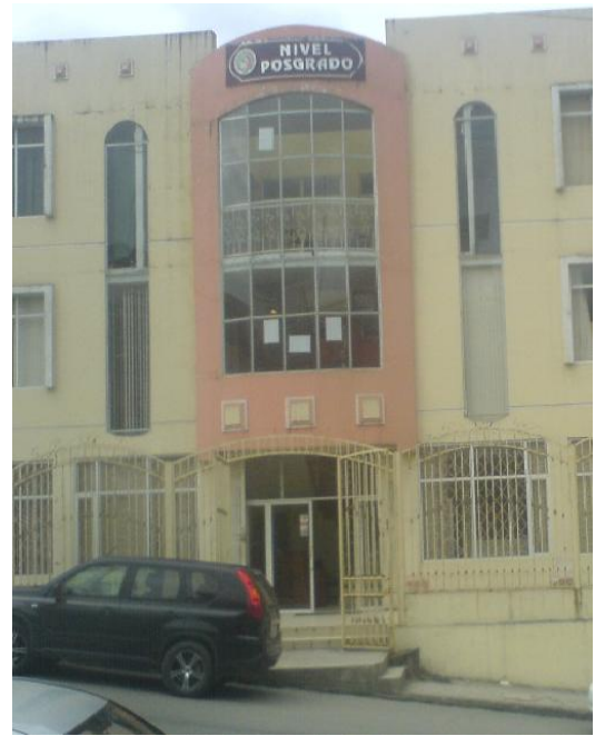
Figura 108. Bloque Posgrado Salud
