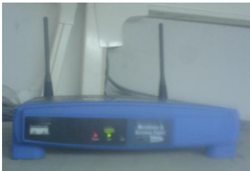
Figura 113. Nodo 3 (3er piso Nominas)
