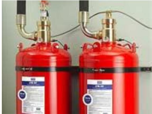
**Figura 49. Tanques de FM-200**
