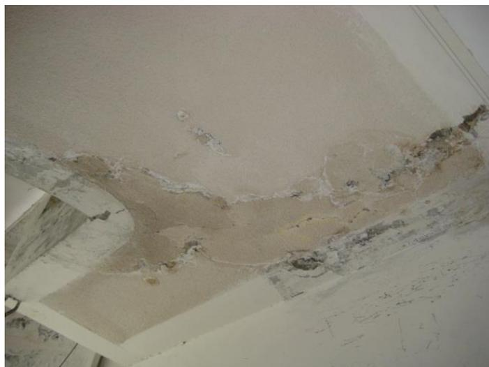
**Figura 31. Filtraciones de Líquidos en la Sala de Servidores**
