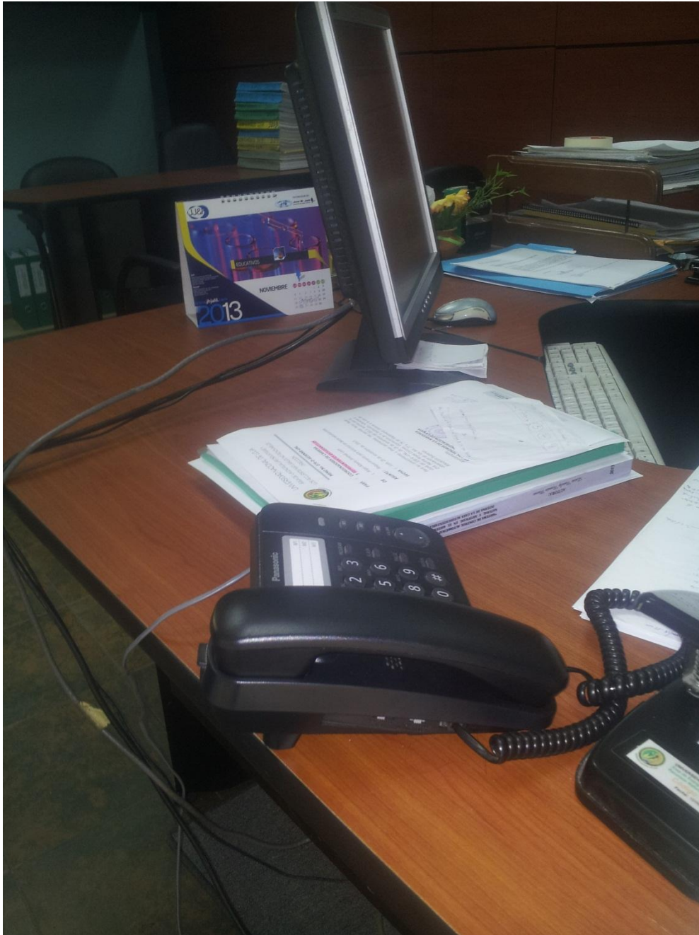
Figura 88. Implementación teléfono Convencional
