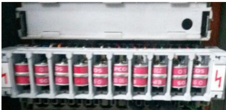
Figura 83. Protección líneas telefónicas
