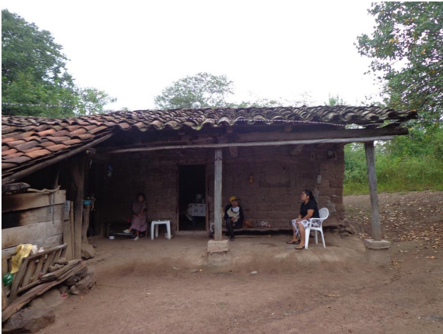
Fig. 10 Fuente: Guido torres Vista panorámica del hogar del anciano
