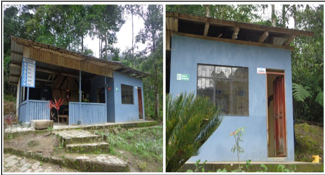
Fotografía 4: Caseta de guardia y bodega.
