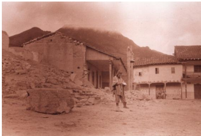
Fig. 32. Restos de la demolición de la Iglesia y Cacique. http://leyen-dasytradicionesandinas.blogspot.com/2012/03/chuquiribamba-que-sabemos-de-este.html
