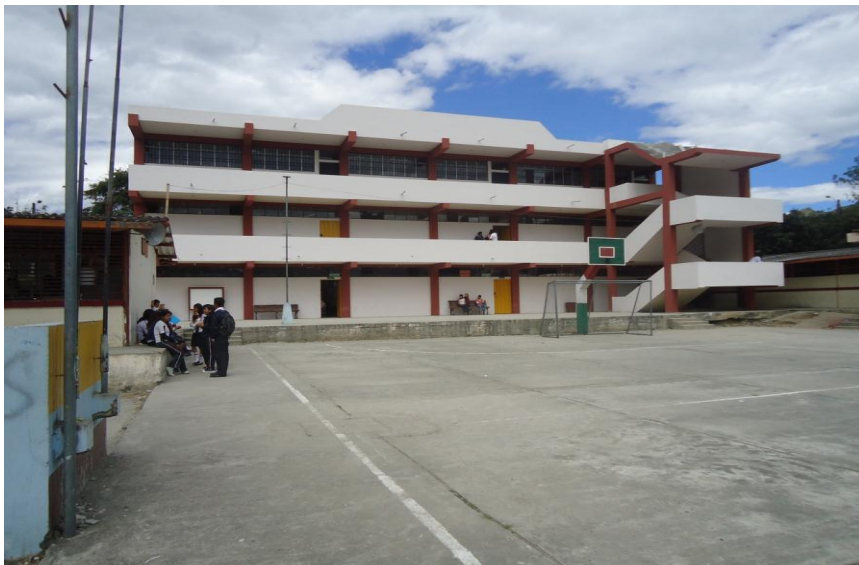
Foto 4.- Bloque de aulas
