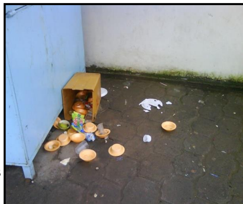
Figura 8: Tacho de recolección de desechos a la entrada del hospital.
