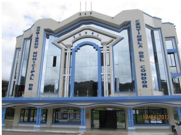
Edificio del Municipio de Centinela del Cóndor
