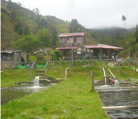
Fotografía N° 71 Vista frontal del parador turístico
