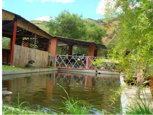
Fotografía N° 83 Área Instalaciones de la piscícola
