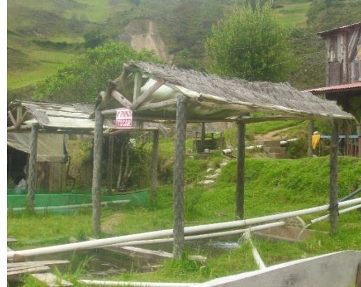
Fotografía N° 75 Panes de protección de estanques
