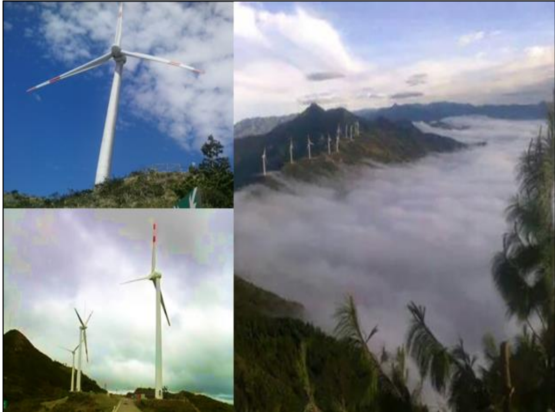
Foto Nº 11 Parque Eólico Villonaco Fuente: Observación Directa Elaboración: Cristina Fernanda Sigüenza Ochoa
