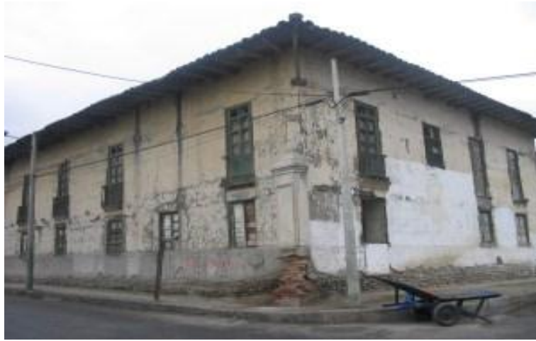
Fotografía N° 1: Centro de convenciones San Juan de Dios
