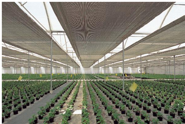
FIGURA 21: Invernadero con sistema de pantallas térmicas
