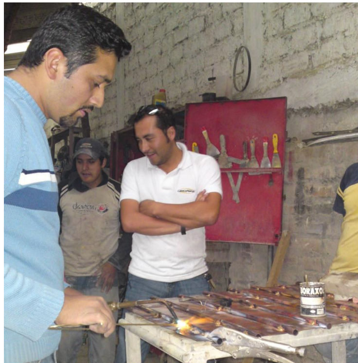
Fig.32. Soldado de la tubería de cobre sobre la plancha acanalada
