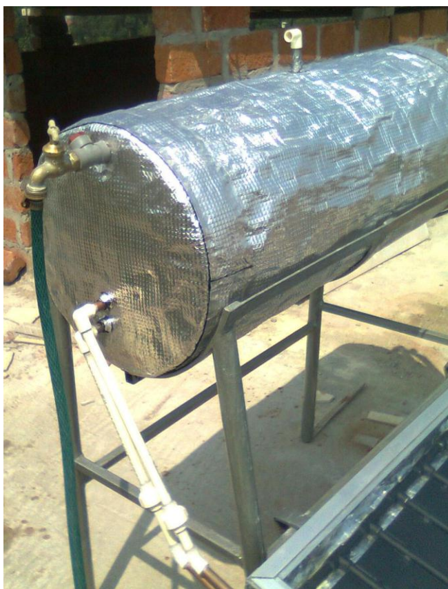
Fig. 34. Tanque de almacenamiento térmico
