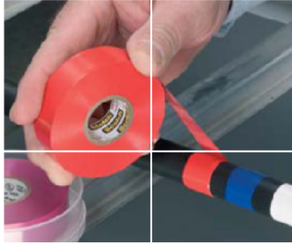
Figura 7. Identificación de cables.
