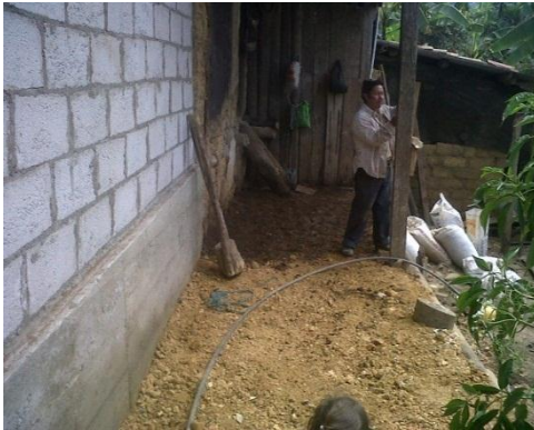
Foto 5: Construcción del galpón
