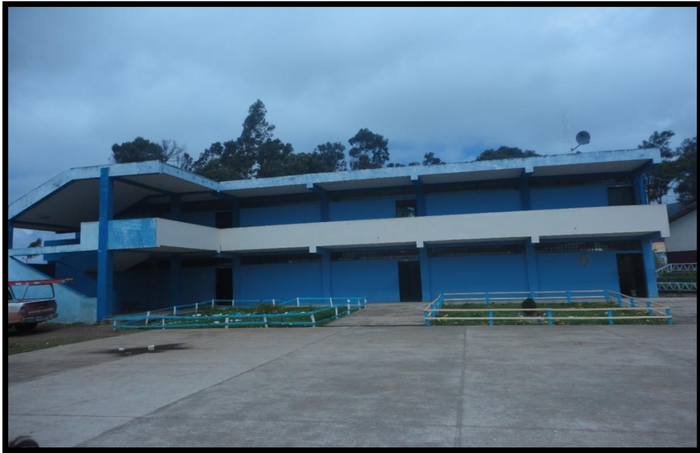
ILUSTRACIÓN 48. INSTALACIONES DE LA UNIDAD EDUCATIVA "FERNANDO SUAREZ PALACIO"
