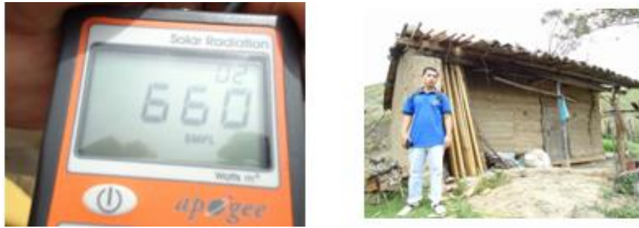
Fig. 38. Inspección realizada en el sector Miyugo.
