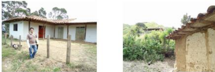
Fig. 39. Casa comunal, y domicilios del sector Miyugo.
