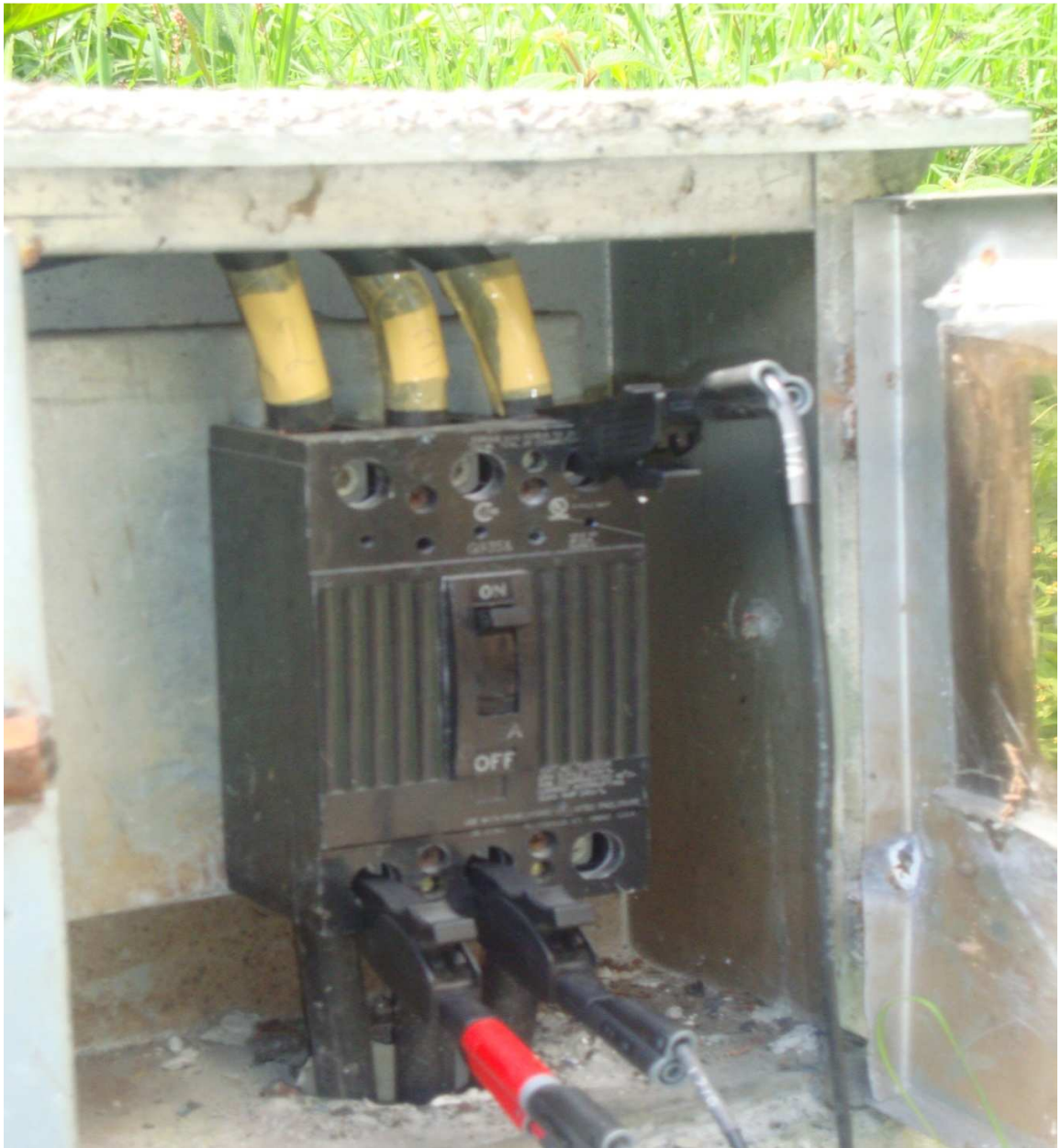
Ubicación pinzas de voltaje Fluke 1743 nodo principal
