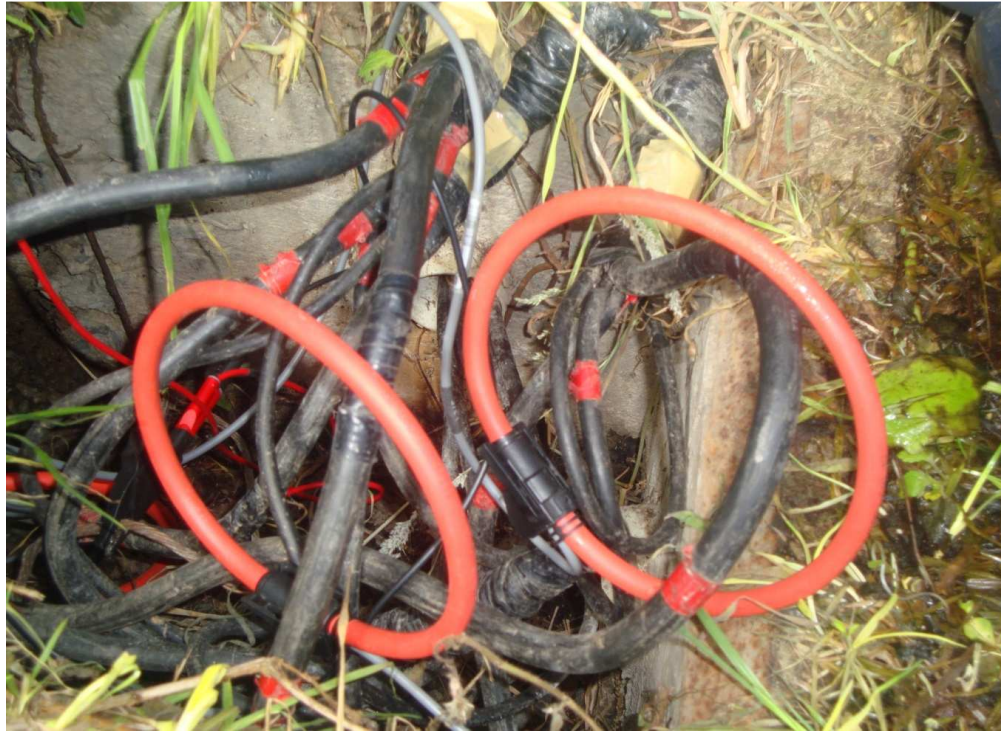
Instalación pinzas amperimétricas
