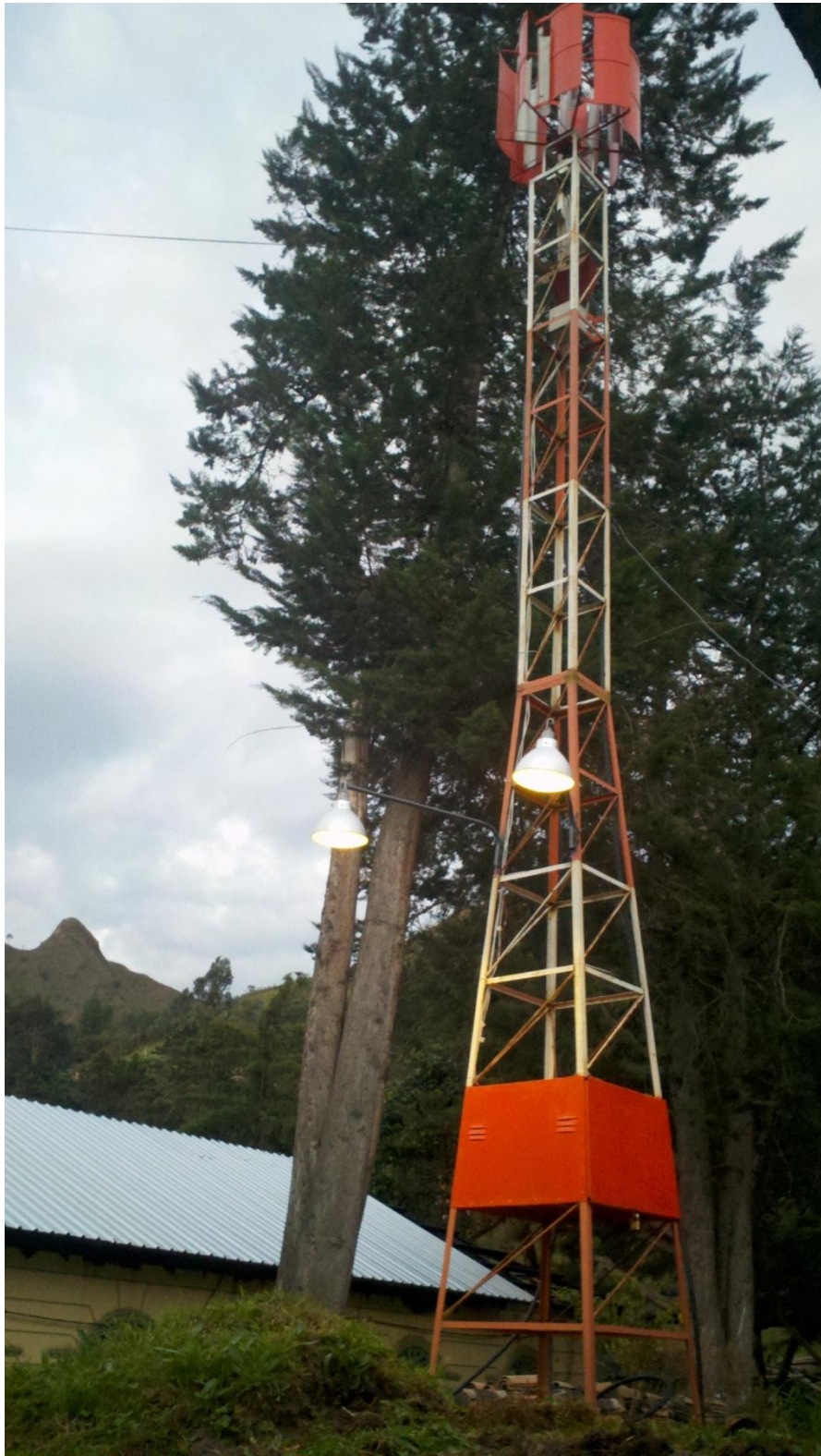
Fotografía 5. Instalación del sistema de encendido automático
