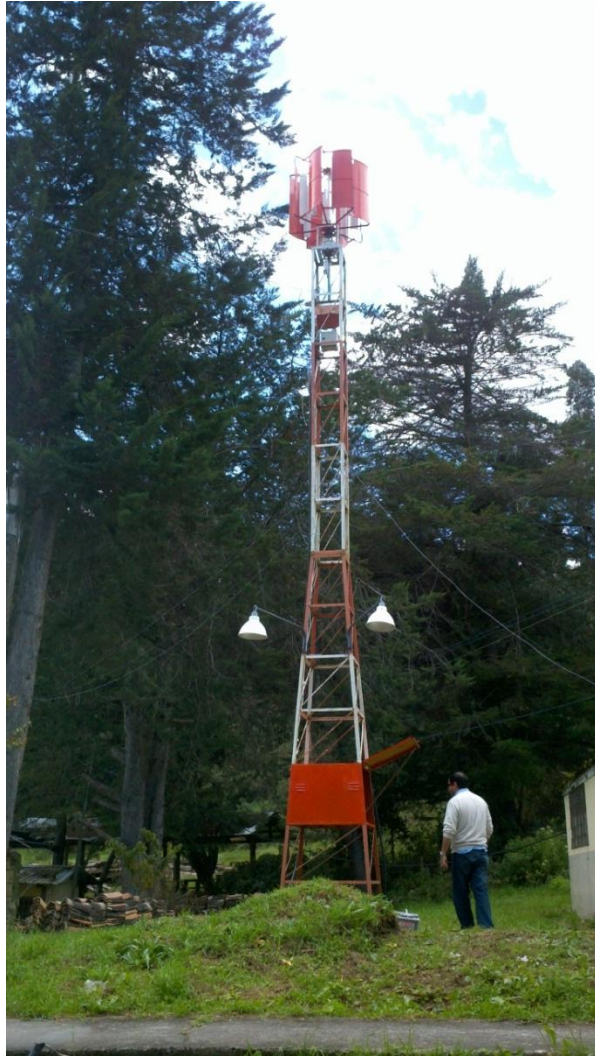
Fotografía 2. Montaje de luminarias y construcción de la caja para el sistema de control
