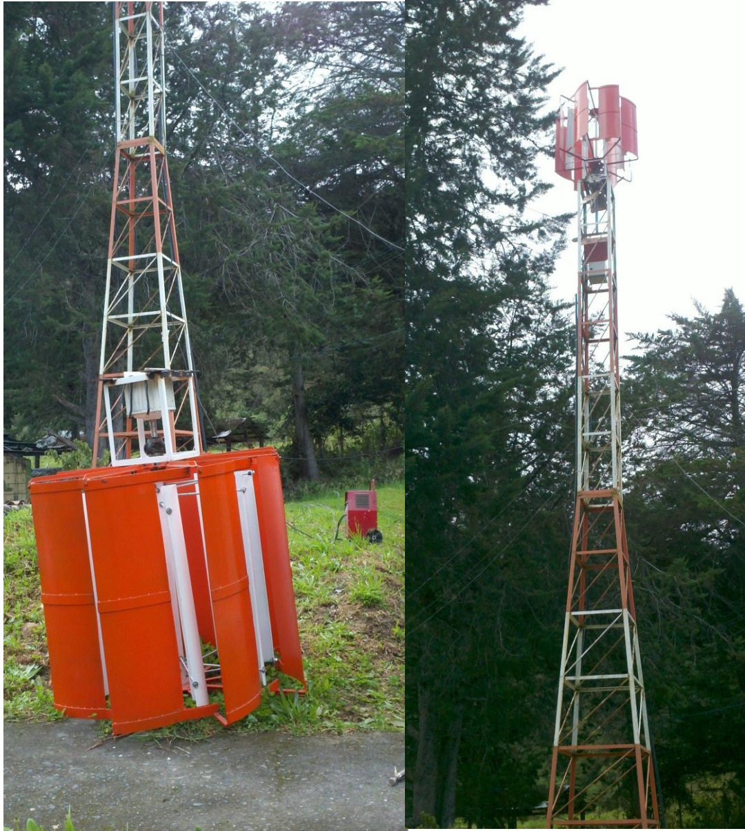
Figura 58. Montaje de la turbina y generador en la torre.
