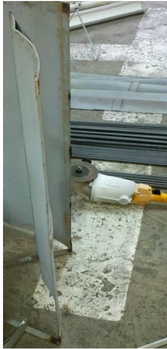
Figura 46. Proceso de corte de direccionadores de la carcasa de toberas.
