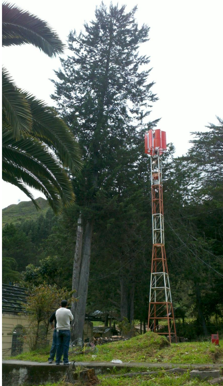
Fotografía 1. Instalación del aerogenerador en la torre
