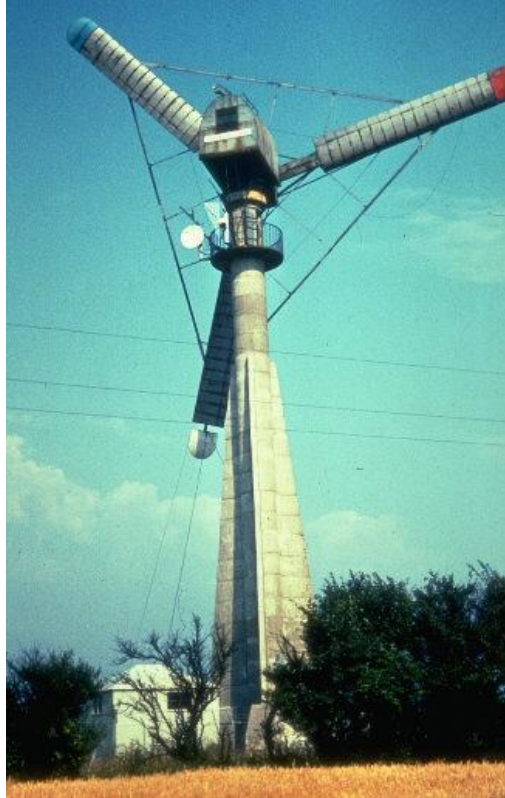
Figura 3. El primer aerogenerador de corriente alterna.
