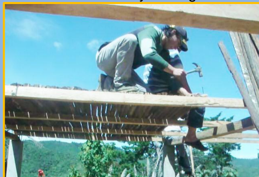
Colocación del techo de chonta
