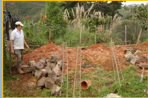
Cadenas de hierro listas para ser colocadas en los hoyos
