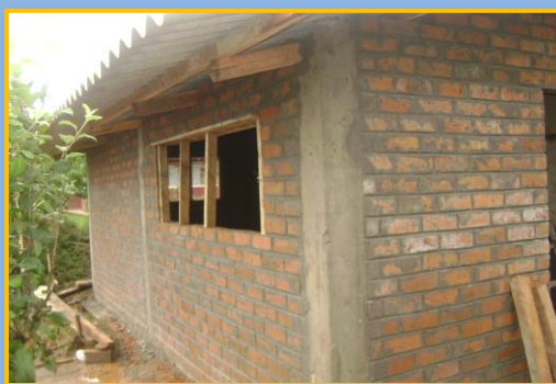
Mampostería terminada de la parte externa
