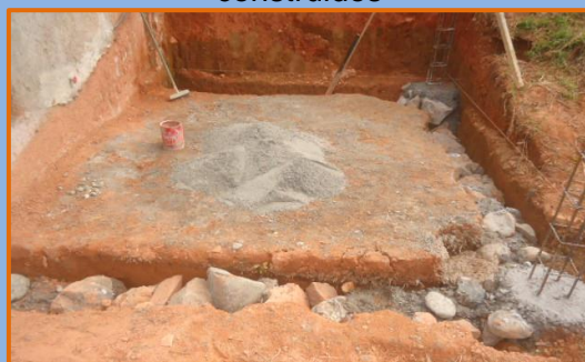
Base de columnas fundidas
