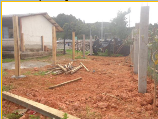
Columnas de madera y hormigón fundidas
