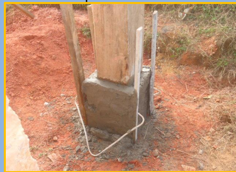
Fundido de base de la viga de madera
