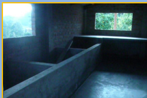
Mesón construido y piso fundido
