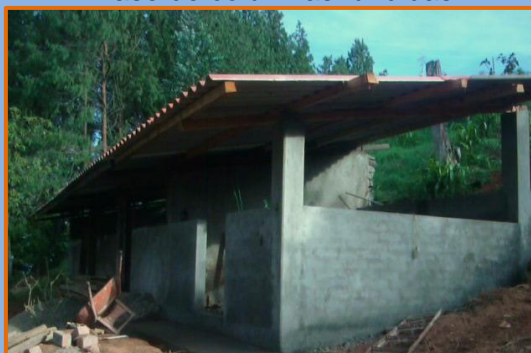
Área de maternidad construida en un 80%
