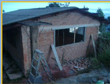
Plataforma de metal colocada en la viga de madera y apertura de ventana en el galpón
