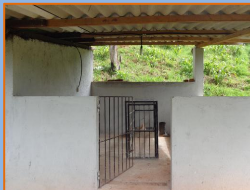
Área de maternidad terminada y adecuada
