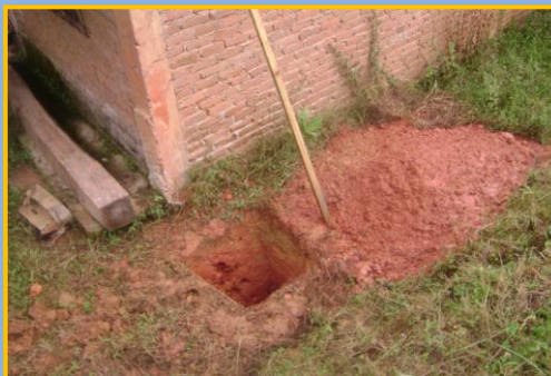
Hoyo construido para la colocación de la viga
