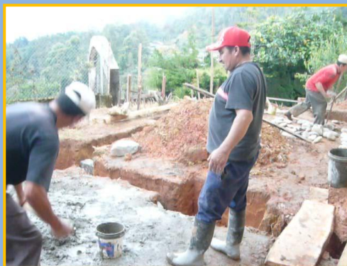
Hoyos construidos para las columnas y cadenas de base del galpón
