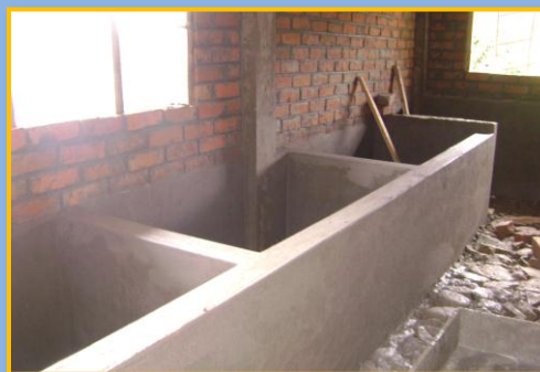
Pozas construidas y revestidas
