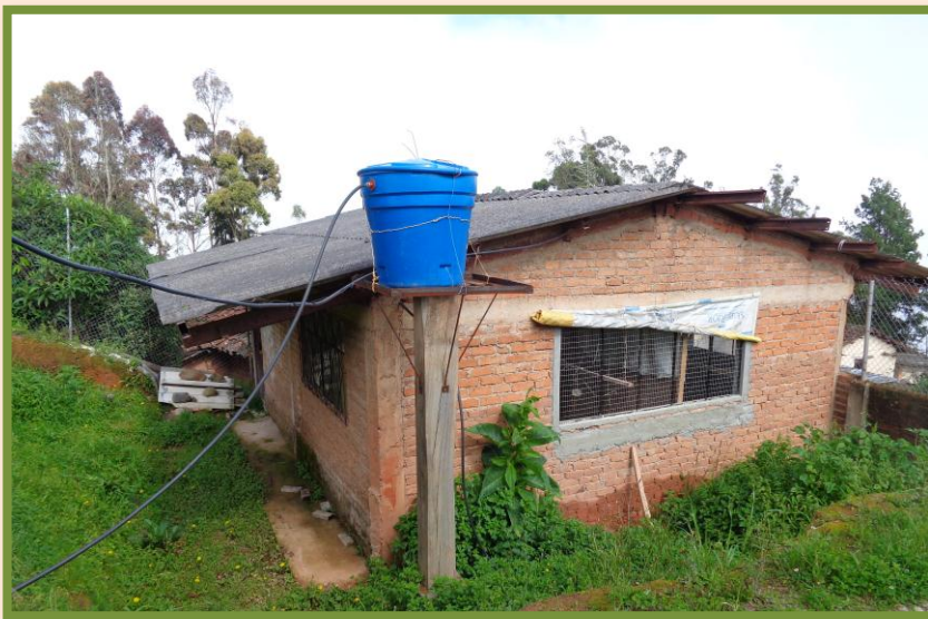
Cisterna instalada en el programa de aves
